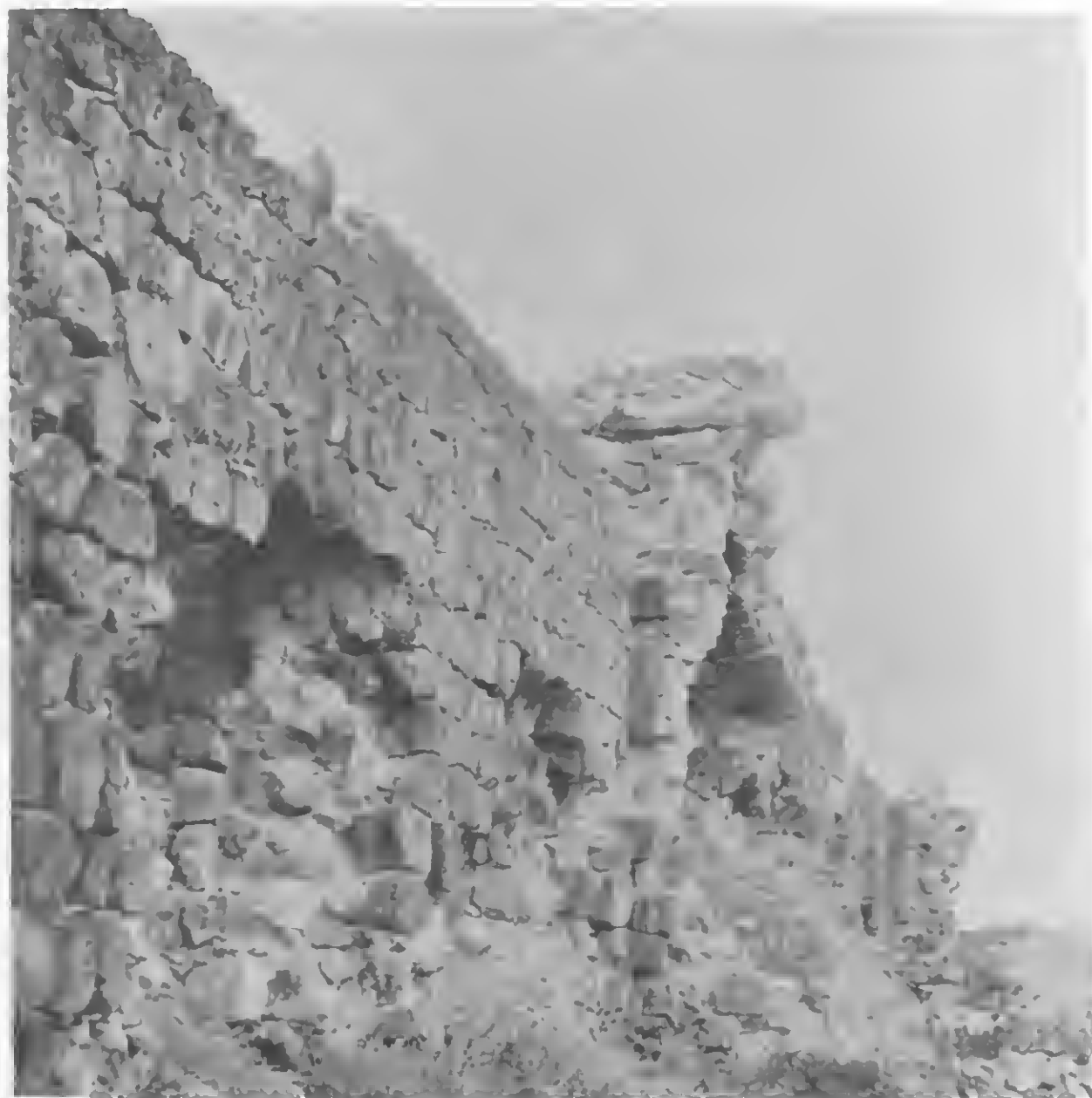
FIG. 3. — Mantzikert : vestige de la muraille d'enceinte de la ville.
